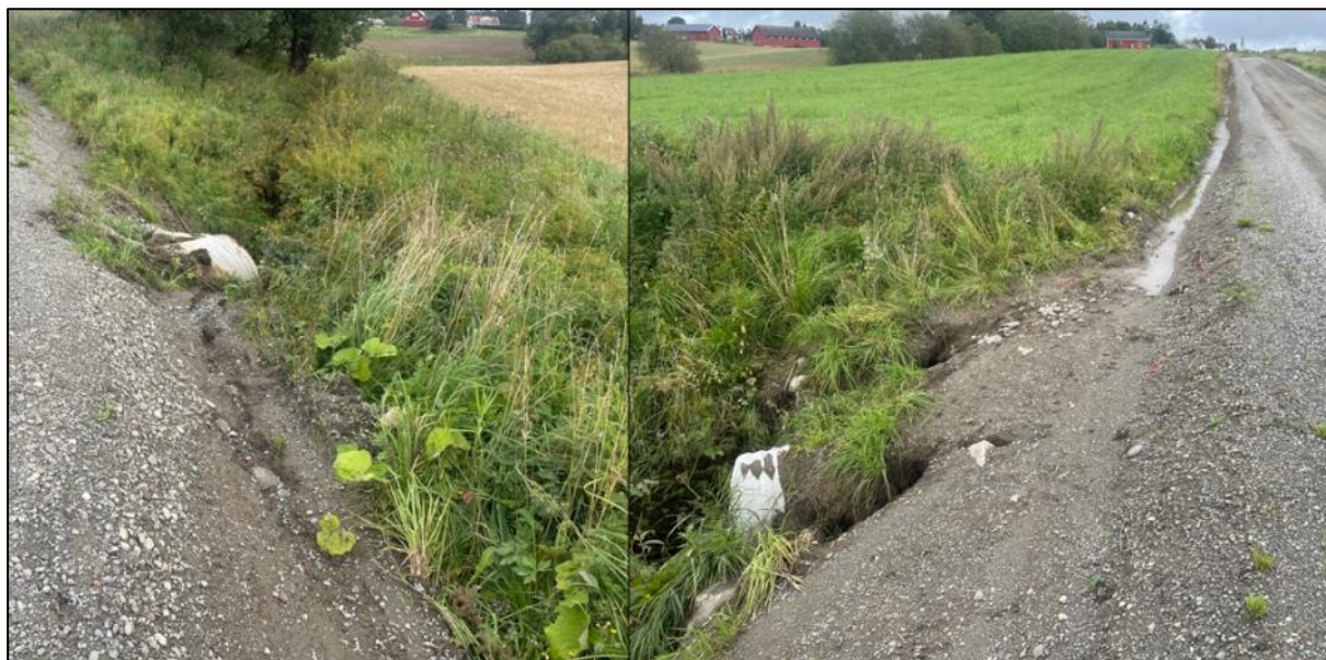
Figur 3-5. Kritisk punkt 8 Dyrbekkveien, er et godt eksempel på erosjon av veiskulder der massene ledes til bekk. Når massene ledes til bekk vil de bidra til å redusere arealet som er tilgjengelig for vann, noe som kan føre til oversvømmelser.
