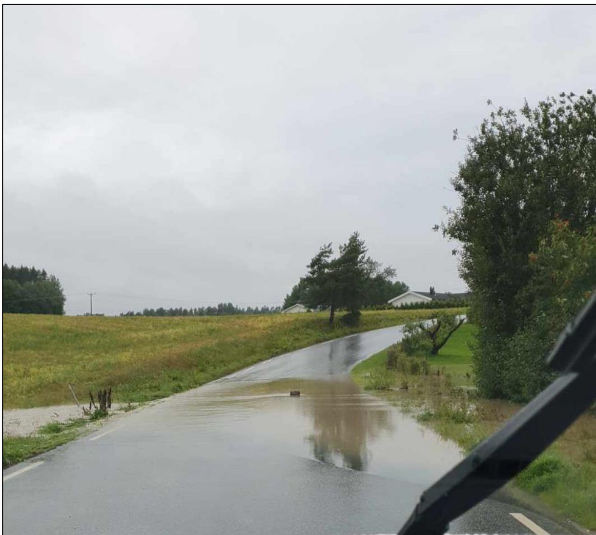
Figur 3-2. Flomvei over Vidnesveien. Innløp til høyre i bildet. Bilde tatt under ekstremværet Hans, ved kritisk punkt 24. Foto: Live Norevik Roberg
